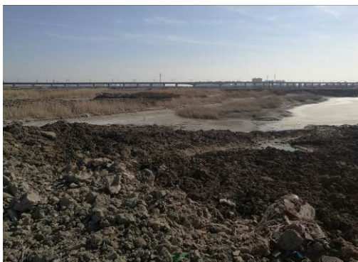
海洋高新区 3#110kV 变电站东侧
