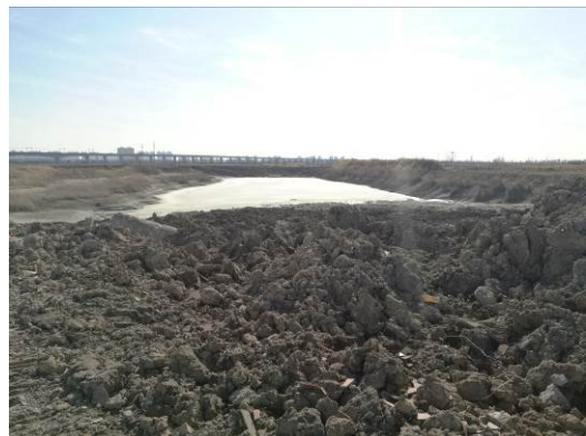
海洋高新区 3#110kV 变电站南侧
